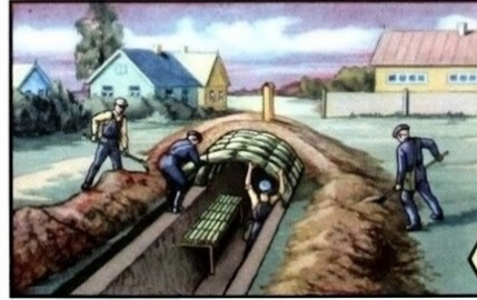
Устройство укрытия из арочных хворостяных или камышовых фашин
